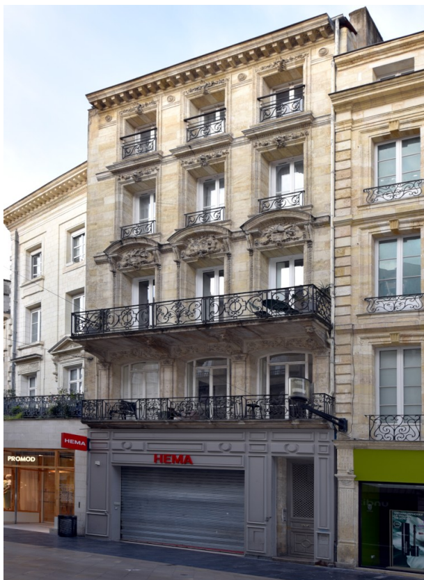
Figure 27: L'immeuble du 73 rue Sainte Catherine
