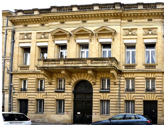
Figure 38: L'immeuble du 22 rue Castéja Photo : Jaume Camin 12 mars 2025
