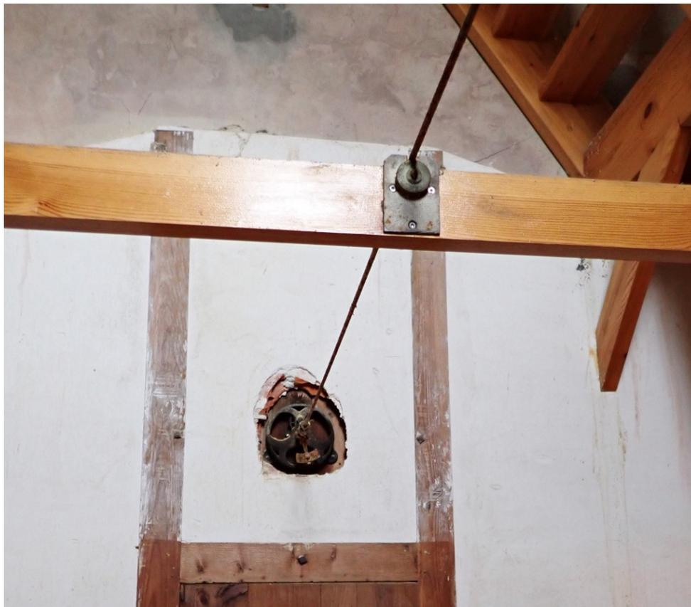
Figure 10: Arbre de transmission des aiguilles
